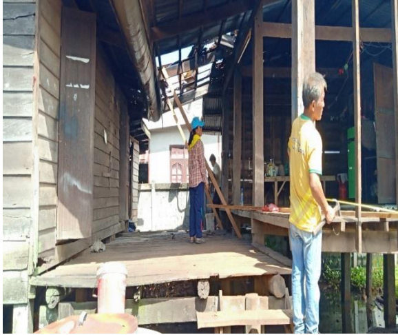
ภาพขณะทำการซ่อมแซม
